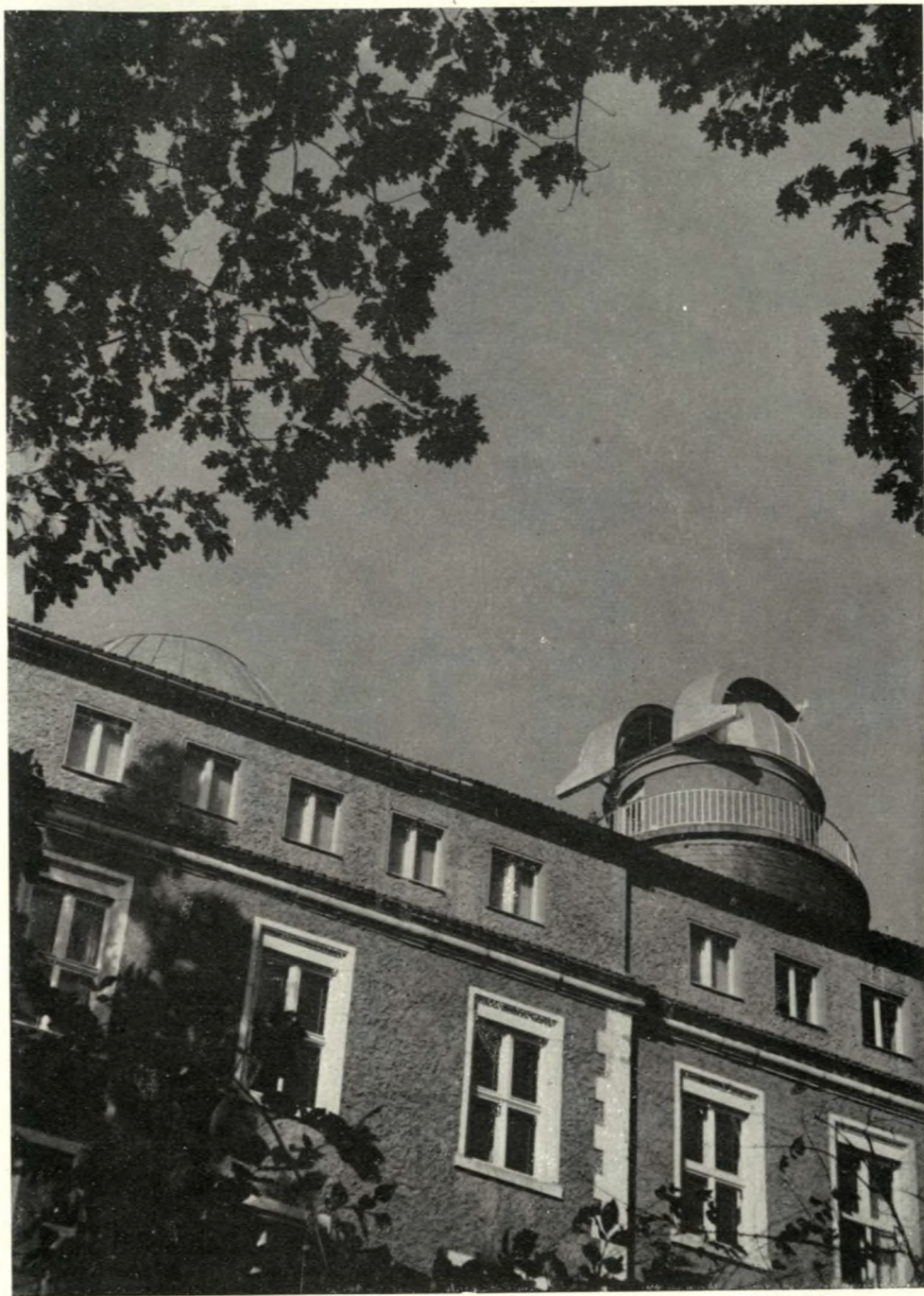
Pětimetrová kopule na hvězdárně v Bautzenu. (Ke zprávě na str. 242.)
