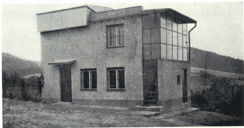
Hvězdárna v Moravské Třebové. Nahoře budova pozorovatelná, dole hlavní dalekohled. (Ke zprávě na str. 18—19.)
