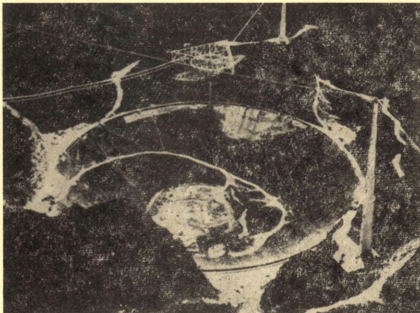
Parabolické zrcadlo o průměru 300 m, které je uloženo ve skalní prohlubni (Arecibo, Puerto-Rico).
