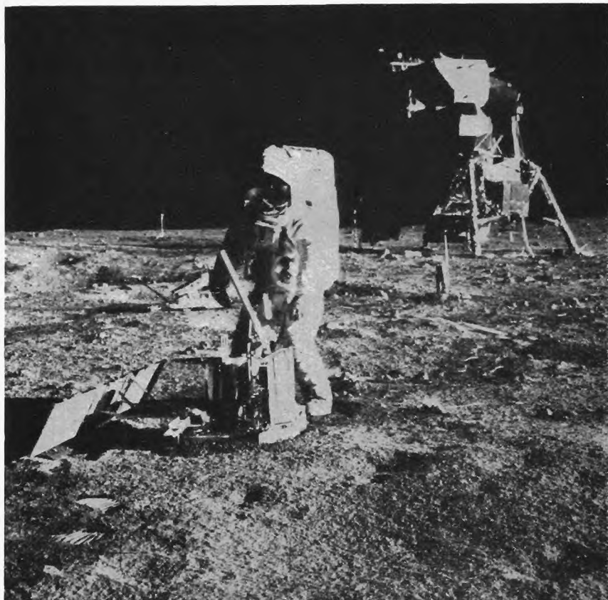
Astronaut Aldrin instaluje na měsíčním povrchu seismometr, vpravo v pozadí je lunární modul Apolla 11. — Na čtvrté str. obálky je pohled na Zemi z paluby Apolla 11.
