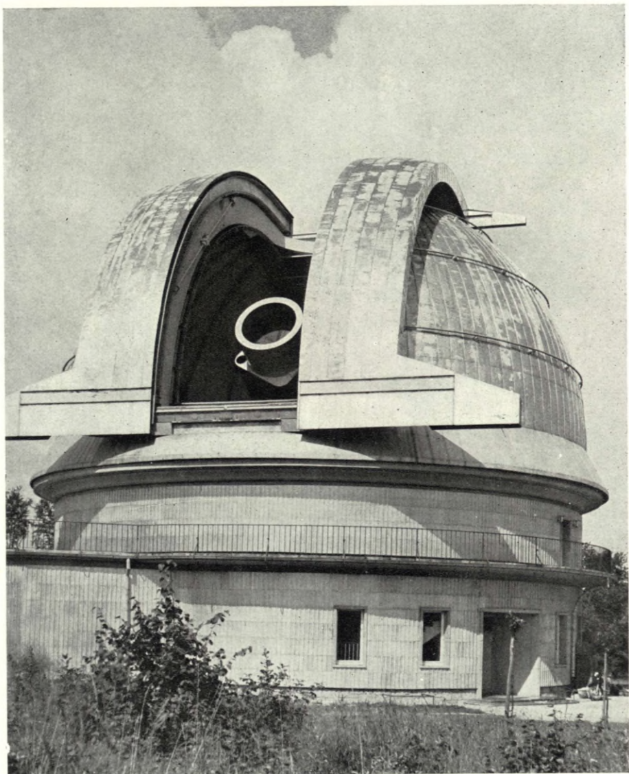
Dvacetimetrová kopule dvoumetrového univerzálního zrcadlového dalekohledu observatoře Karla Schwarzschilda v Tautenburgu.
