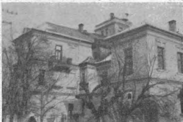
Správní budova s meteorologic- kou observatoří v Hurbanově
