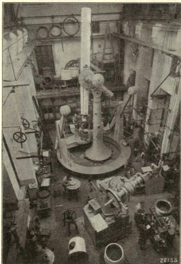
Obr. 1. 400-mm refraktor Vatikánské hvězdárny v Zeissových dílnách.
