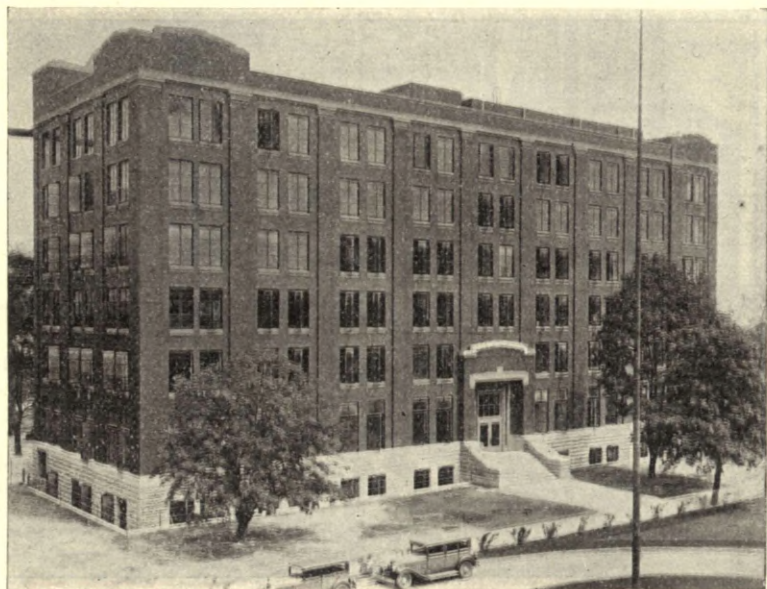
Celkový pohled na výzkumný ústav „Kodak“ v Rochestru (USA).
