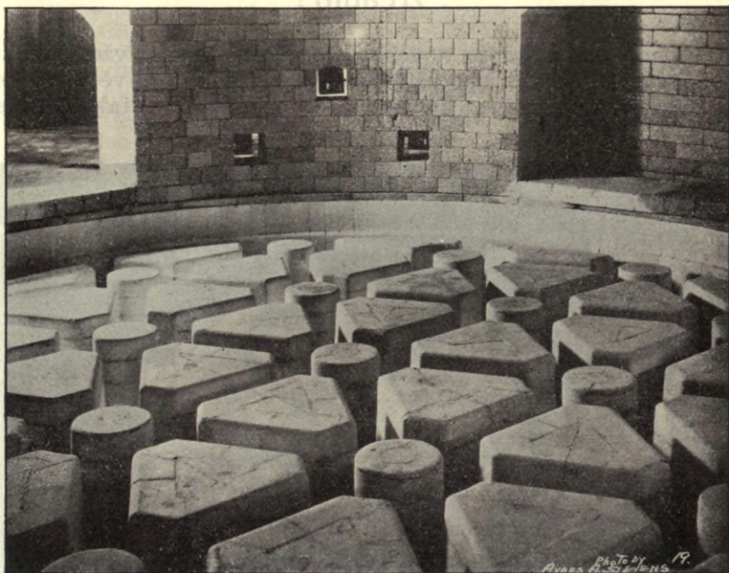
Keramická forma pro třímetrové zrcadlo.
