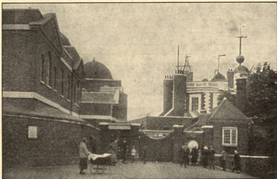
Obr. 1. Vchod do hvězdárny v Greenwichi. Vpravo původní Flamsteedova stavba.
